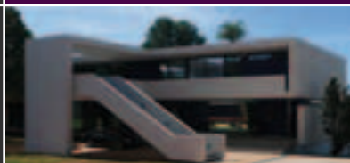
ČESKÁ STAVBA V ZAHRANIČÍ / CENA NADACE PRO ROZVOJ ARCHITEKTURY A STAVITELSTVÍ / Rekonstrukce zastupitelského úřadu ČR v Brazílii
