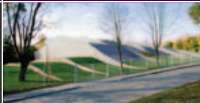
Krytý plavecký bazén v Litomyšli
