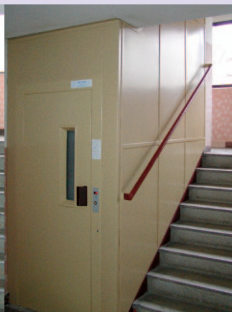
Výtah po rekonstrukci
