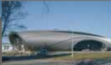
43. Modernizace Letiště III. etapa Olšovská vrata – Letiště 1. 10. 2009, 9.00 – 10.00
