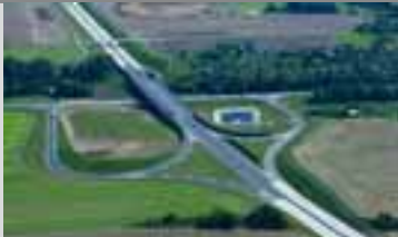
1. Dálnice D47, stavba 4707 Bílovec - Ostrava Úsek mezi MUK Bravantice a MUK Klímkovice 23. 9. 2009, 9.00 – 16.00
