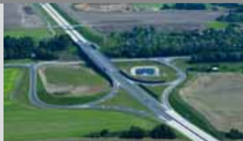
1. Dálnice D47, stavba 4707 Bílovec - Ostrava Úsek mezi MÚK Bravantice a MÚK Klímkovice 23. 9. 2009, 9.00 – 16.00
