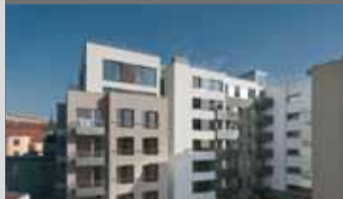
36. Rezidence Prokopova – bytový dům Praha Prokopova 2856, Praha 3 - Žižkov 24. 9. 2009, 12.00 – 19.00
