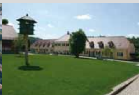
23. Rekonstrukce hospodářského dvora a zámku Ostrov
