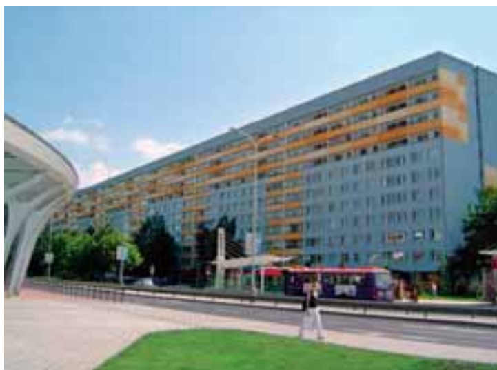
Největší stavba realizovaná firmou SAPADO – dům v ulici Vysočanská hned u metra Střížkov v Praze – Proseku
