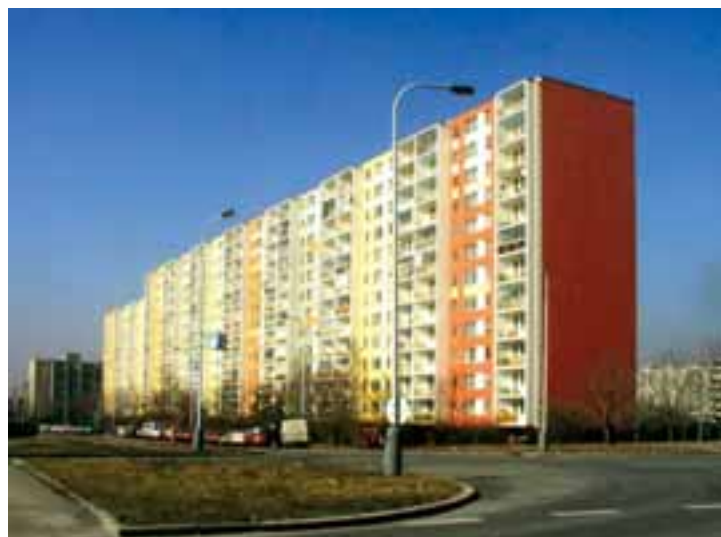
Opravené domy v ulici Mazurská (Praha – Bohnice) jsou rovněž dílem firmy SAPADO
