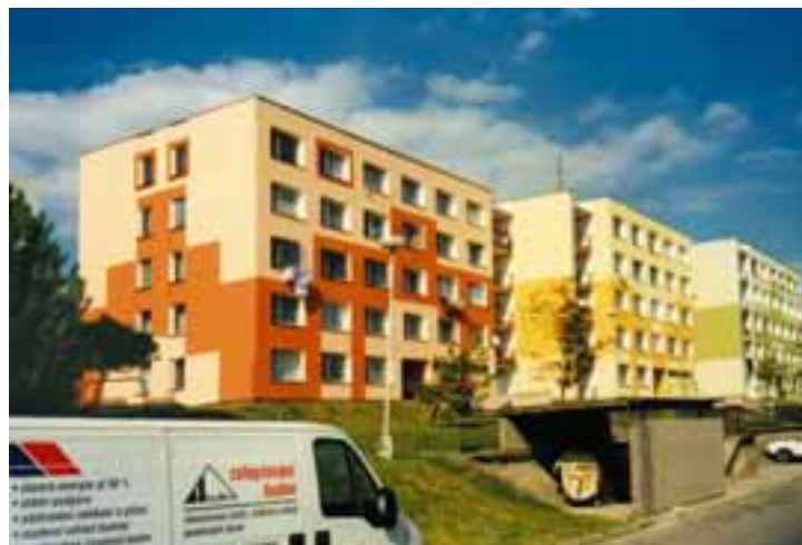
Regenerace paneláků ve Vimperku
