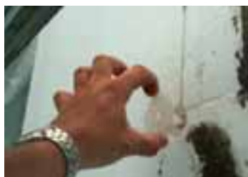
Nadměrný otvor pro hmoždinku – uvolnění
