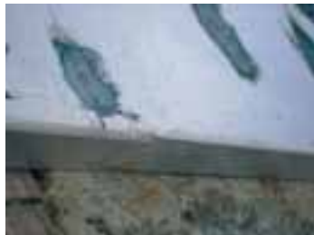
Chybějící spojka zakládací lišty
